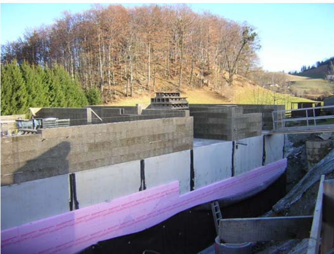
Das Erdgeschoß wird aufgemauert
