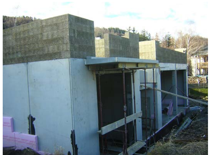
Das Erdgeschoß wird aufgemauert
