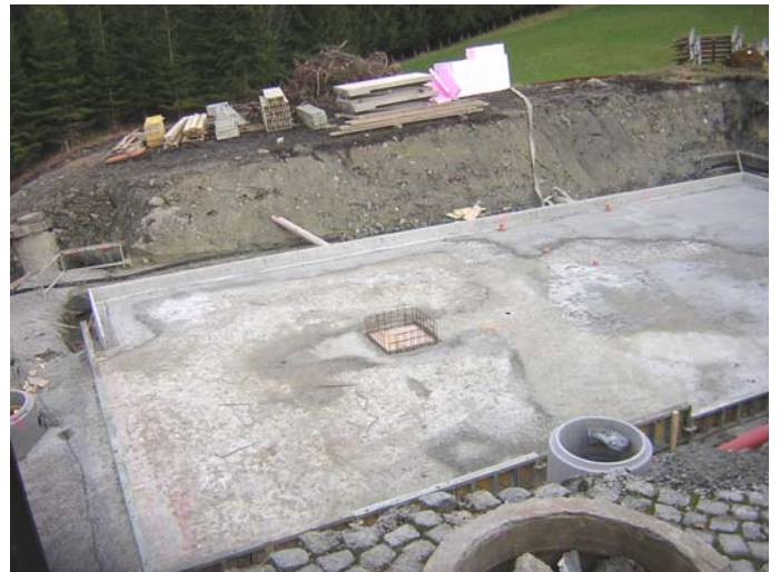
Baubeginn und Errichtung der Bodenplatte
